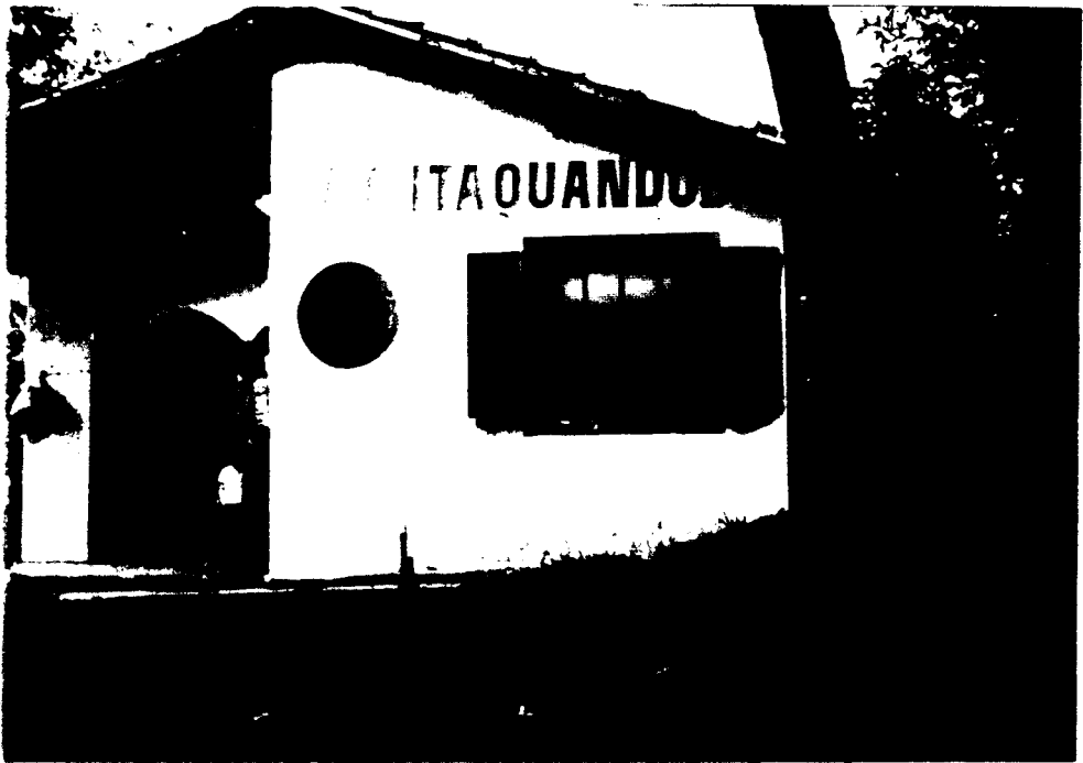
1953 - Casa da comunidade da localidade
