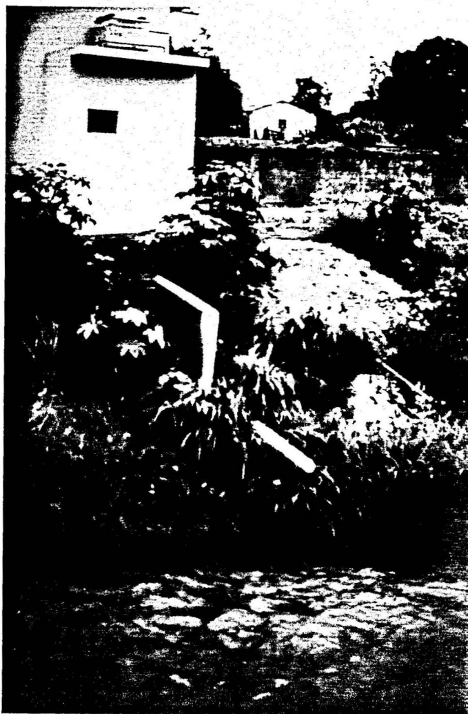
FIGURA 20 - Ligação clandestina no Rio Lençóis, localizada à jusante da ETA
