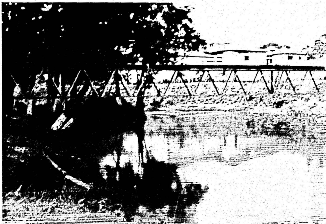
FIGURA 19 - A captação de água no Rio Lençóis ( ETA )
