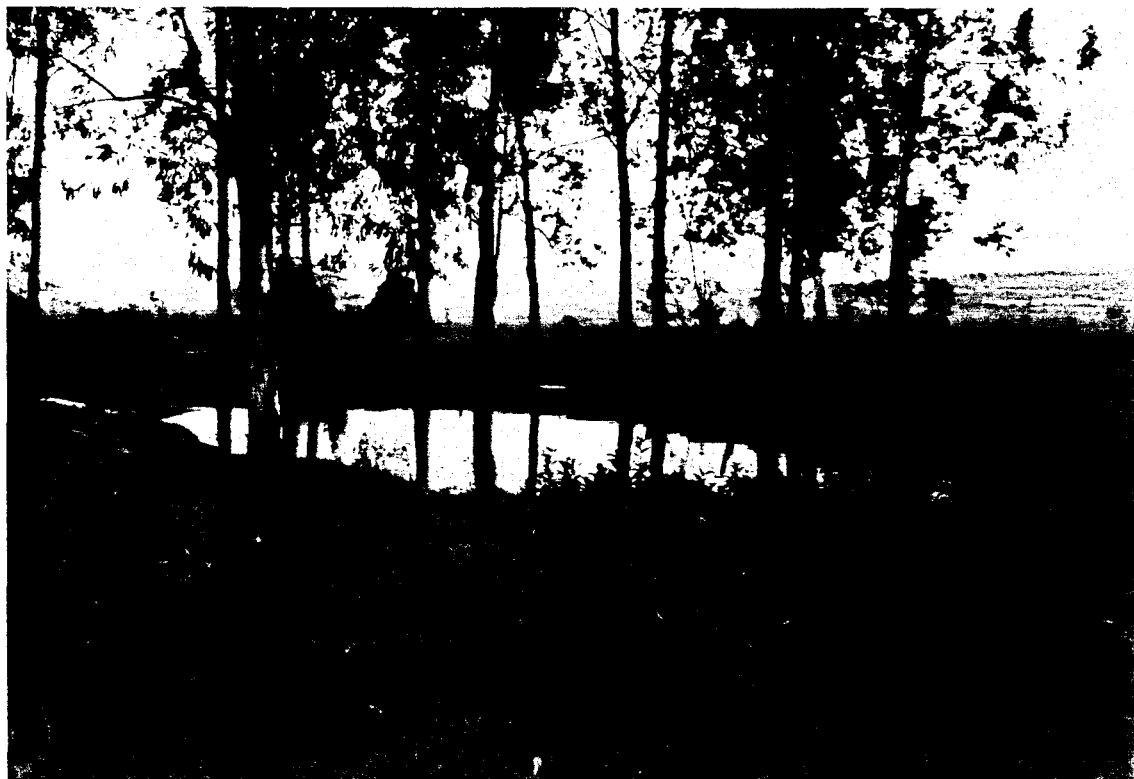
FIGURA 45 - Vista parcial das lagoas de esgoto de Borebi 2ª lagoas.
