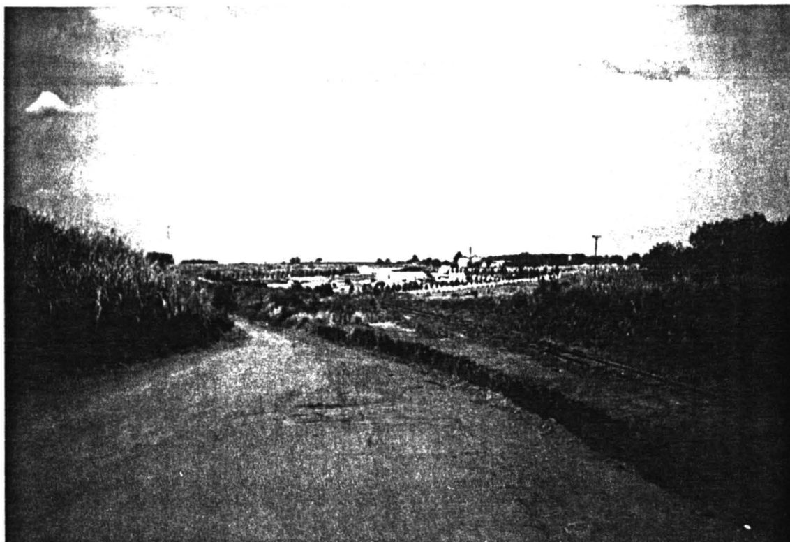
Vista da Usina de Compostagem
