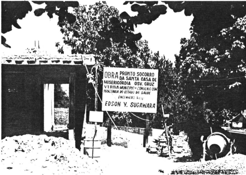
Santa Casa de Misericórdia - Obras do Pronto Socorro
