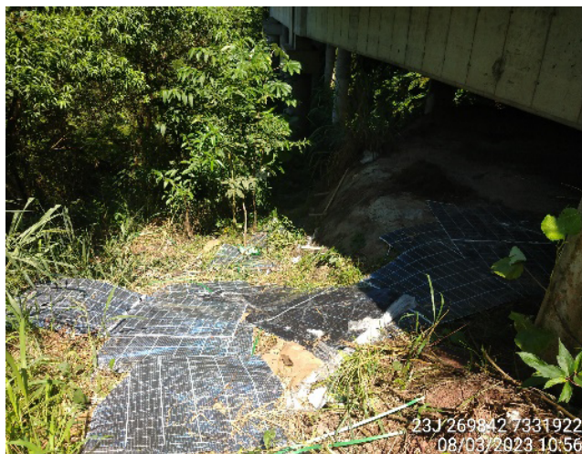
Figura 9 – Restos de carga oriundo de acidente rodoviário na área lateral e sob viaduto Foto: acervo de Rodrigo Tadeu Oliveira Ribeiro
