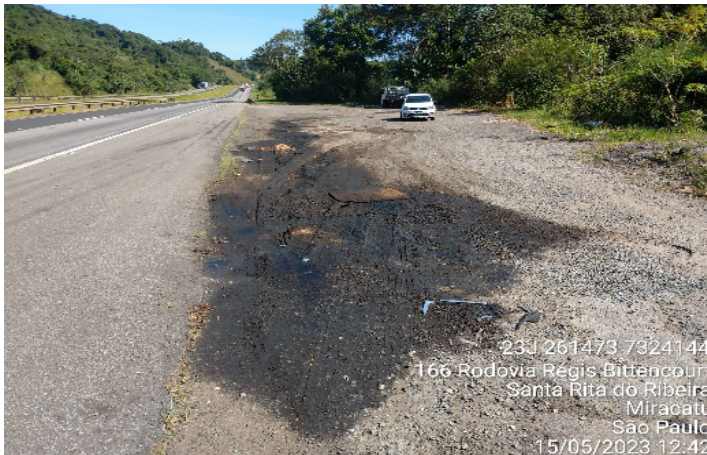
Figura 4 - Margem com indícios de vazamento de óleo lubrificante
