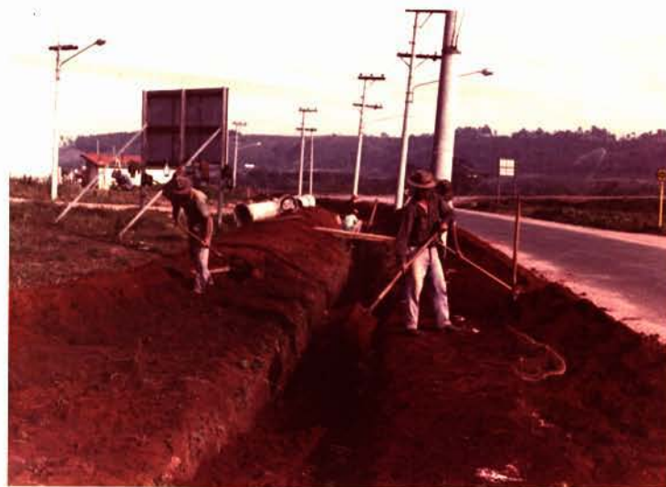
Operários em serviço nas obras de instalação do sistema de captação de águas pluviais.
