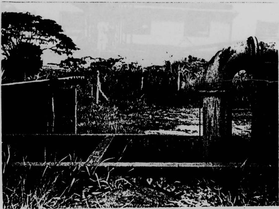
FOTO 4: E.T.A. - DUTO DE CAPTAÇÃO
