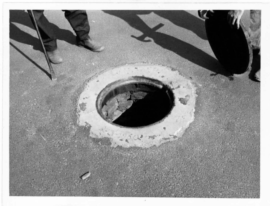
POÇO DE VISITA
