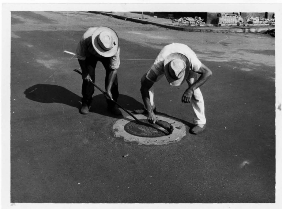
POÇO DE VISITA
