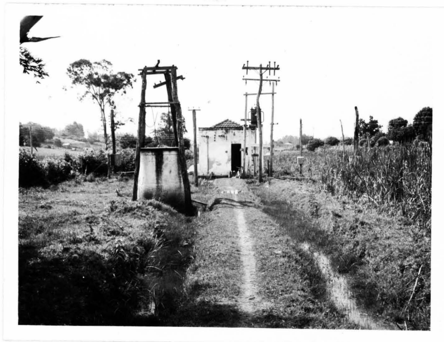
POÇO E CASA DE BOMBAS (VELHA)
