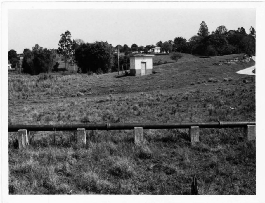
ADUTORA - ÁGUA BRUTA
