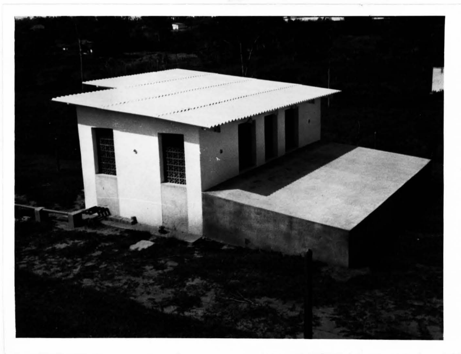
NOVA CASA DE BOMBAS E TRATAMENTO
