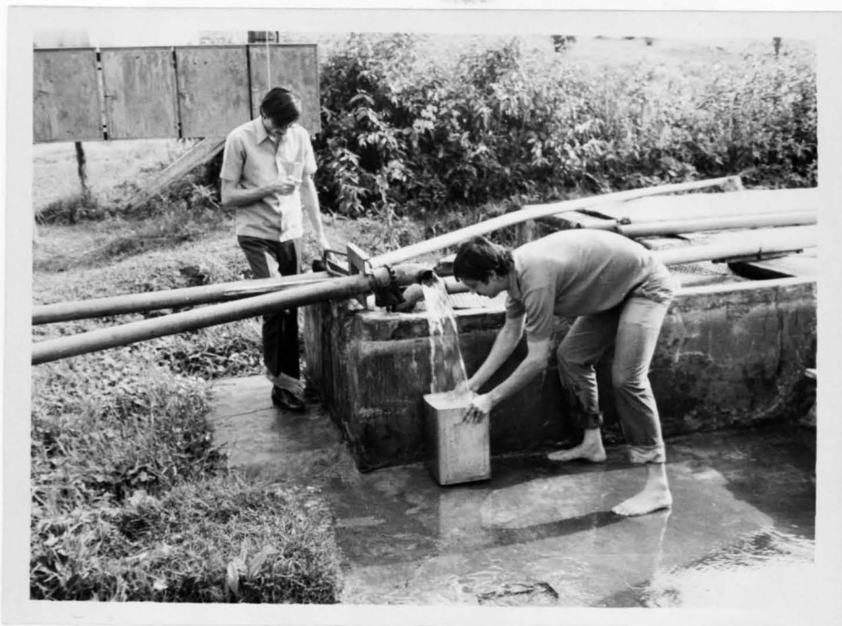
POÇO DE SUCÇÃO
