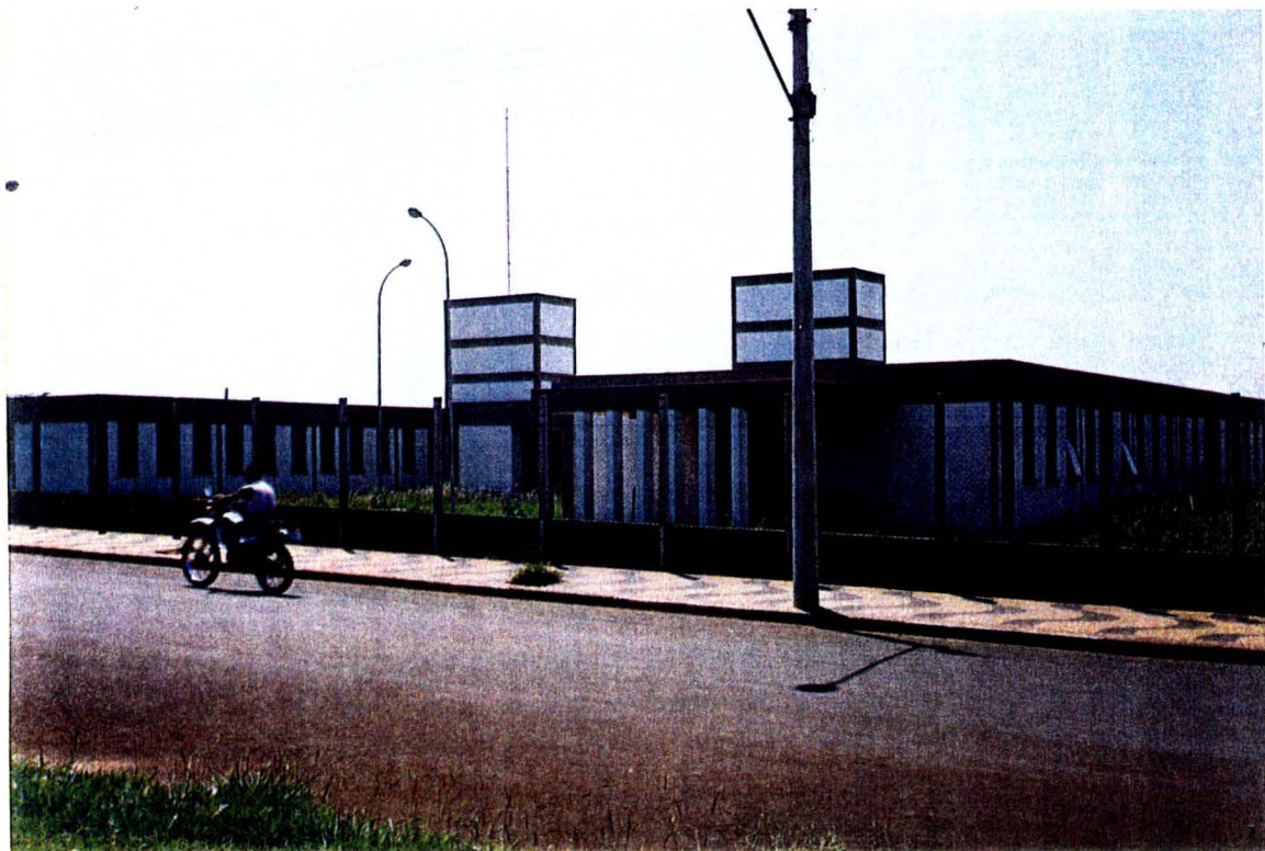
Foto 19 - Futura Unidade de Nível Secundário
