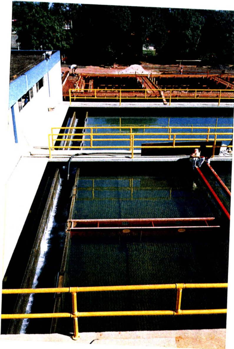
Foto 2 - Vista parcial dos decantadores da ETA existentes e em construção
