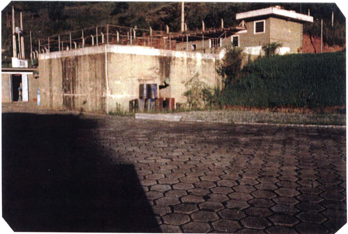
VISTA DA ESTAÇÃO DE TRATAMENTO DE ÁGUA RIBEIRÃO CONQUISTA - COPASA
