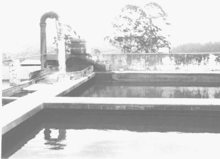
Construção reservatório de água - Mairinque
