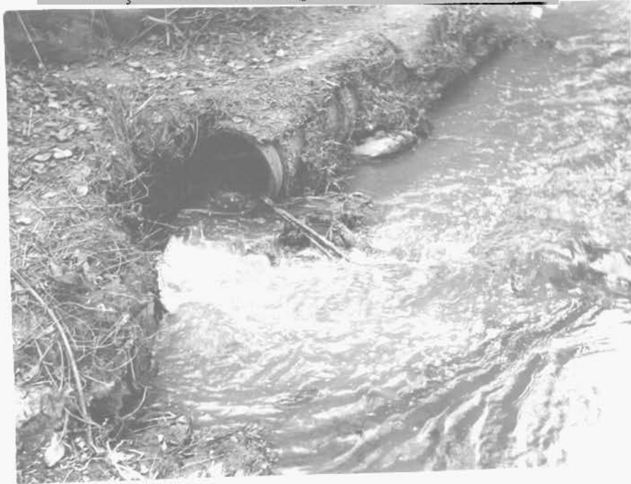
Lançamento do esgoto de alumínio
