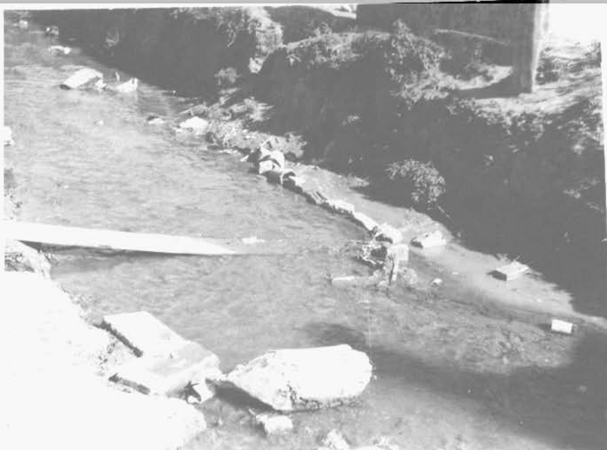
Córrego onde é lançada parte do esgoto
