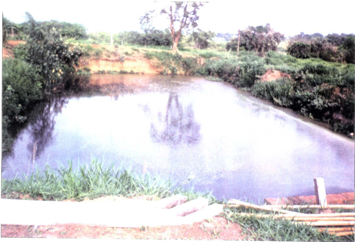
F27. Vista geral da lagoa anaeróbia.
