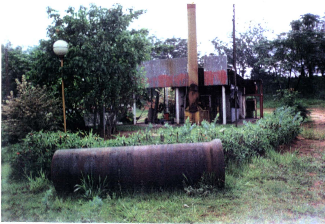
F19. Incinerador municipal.
