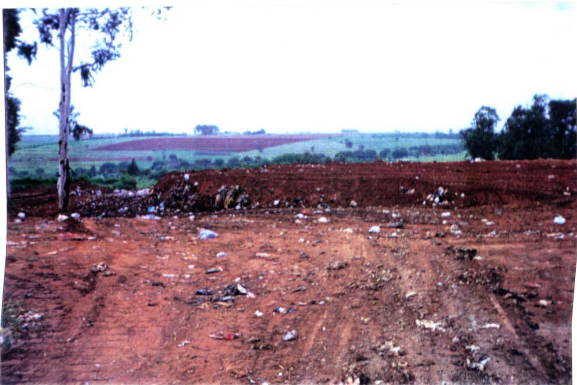
F8. Vista do aterro controlado - fundos do Parque de Reciclagem.
