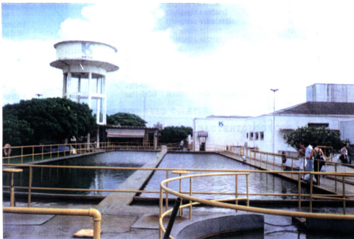
F1 Companhia Sabsesp do Município de Assis. Aspecto do decantador e do reservatório elevado.
