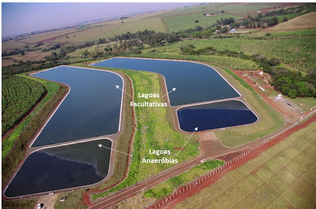
**Figura 44.** Estação de Tratamento de Esgotos por lagoas Sistema Australiano.
