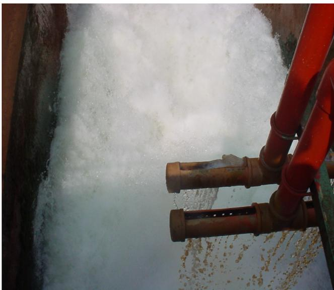
**Figura 27.** Adição de coagulante e alcalinizante no início do processo de tratamento.
