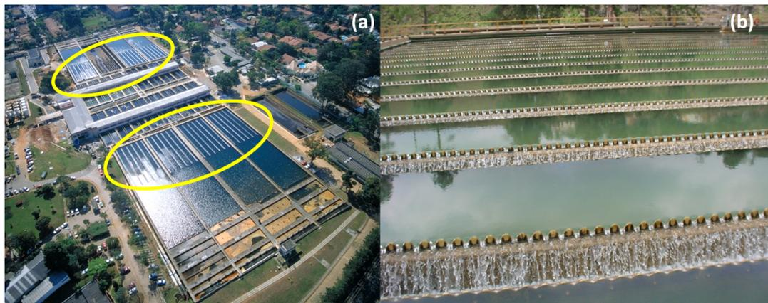
**Figura 29.** (a) Vista aérea de uma ETA, com destaque para a saída dos decantadores.
