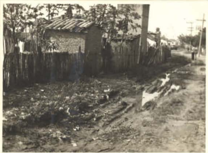
ASPECTO DA RUA BAIA: AGUAS SERVIDAS LANÇADAS EM SUPERFÍCIE
