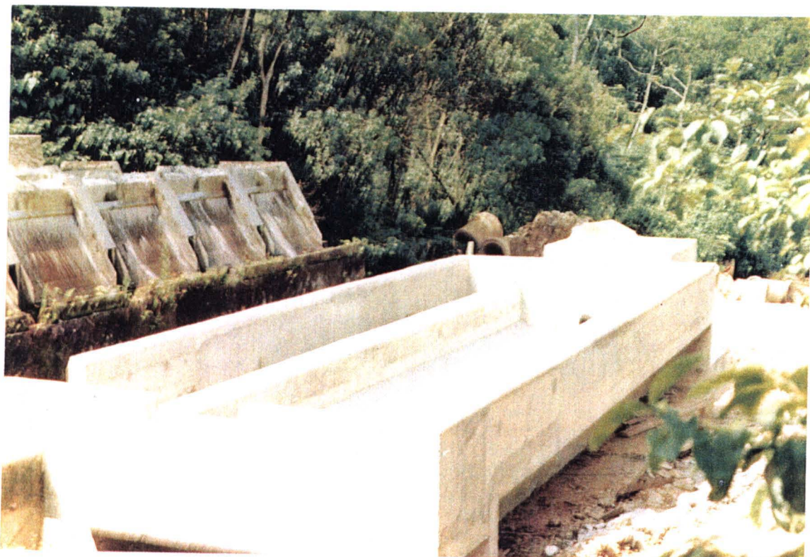
FOTO 18 CONSTRUÇÃO DE FILTRO (OBRAS DE AMPLIAÇÃO) JUNTO A CAPTAÇÃO DO RIO JURUBATUBA. (COTA 75)
