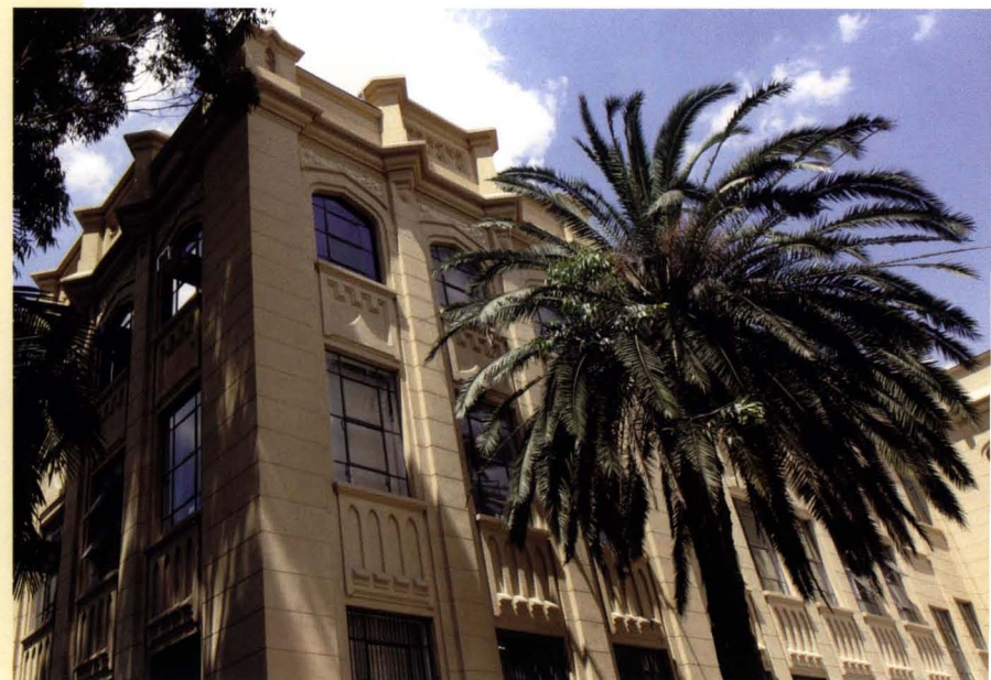
O segundo prédio, também após a restauração The second building after restoration
