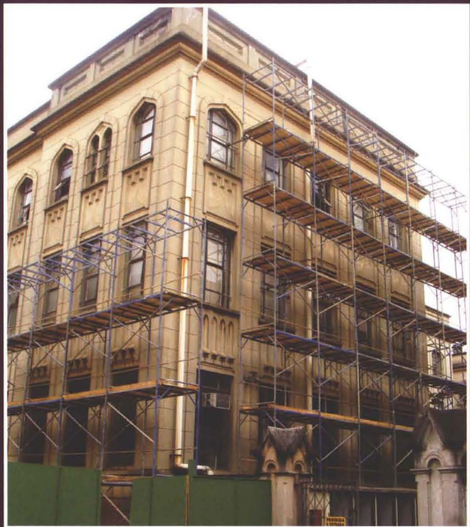
Início da restauração do primeiro prédio
