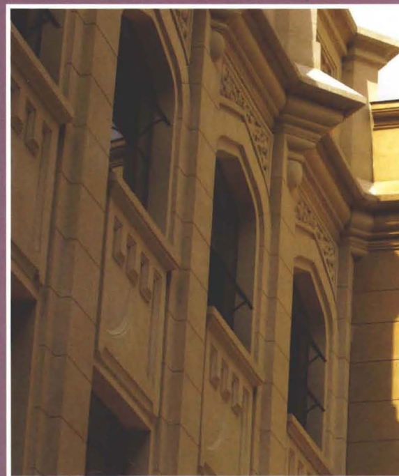
A imagem revela o volume muito maior de detalhes na fachada do primeiro prédio
