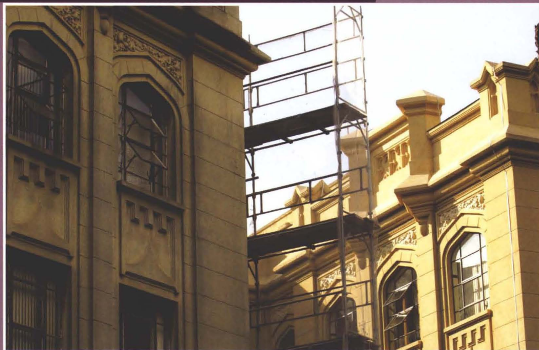
Encontro dos dois edifícios. A cor diferente se explica pelo uso de argamassa importada no primeiro prédio
