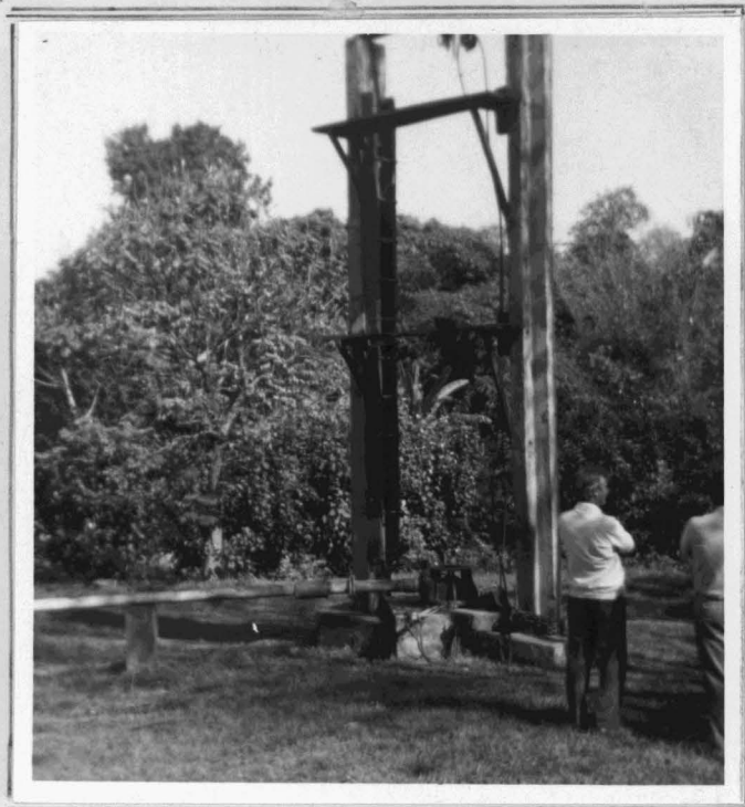
Foto 4: Aspecto geral da localização do poço profundo nº 1.
