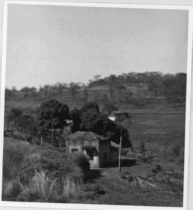
Foto 1 : Visão geral da estação de recalque do manancial do Limeira.
