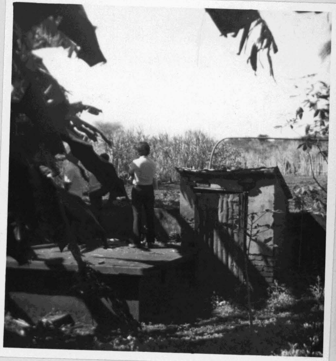
Foto 3 : Vista da caixa de recepção da água proveniente dos drenos do manancial do Bassos.
