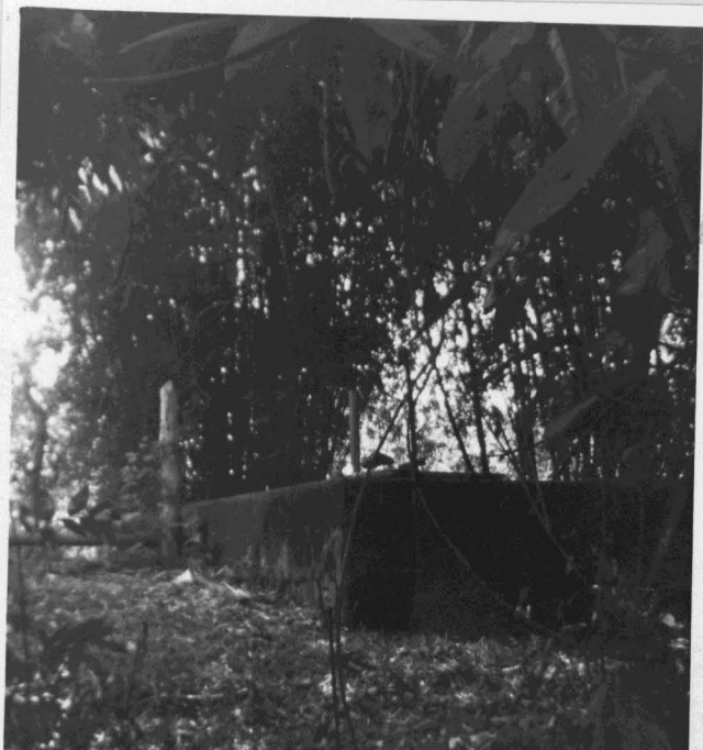
Foto 3 : Vista da caixa de recepção da água proveniente dos drenos do manancial do Bassos.
