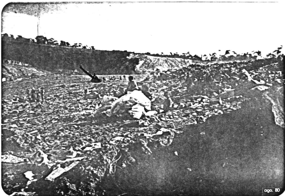
FOTO N° 2 - A seta indica um dos tubos para escape dos gases produzidos.
