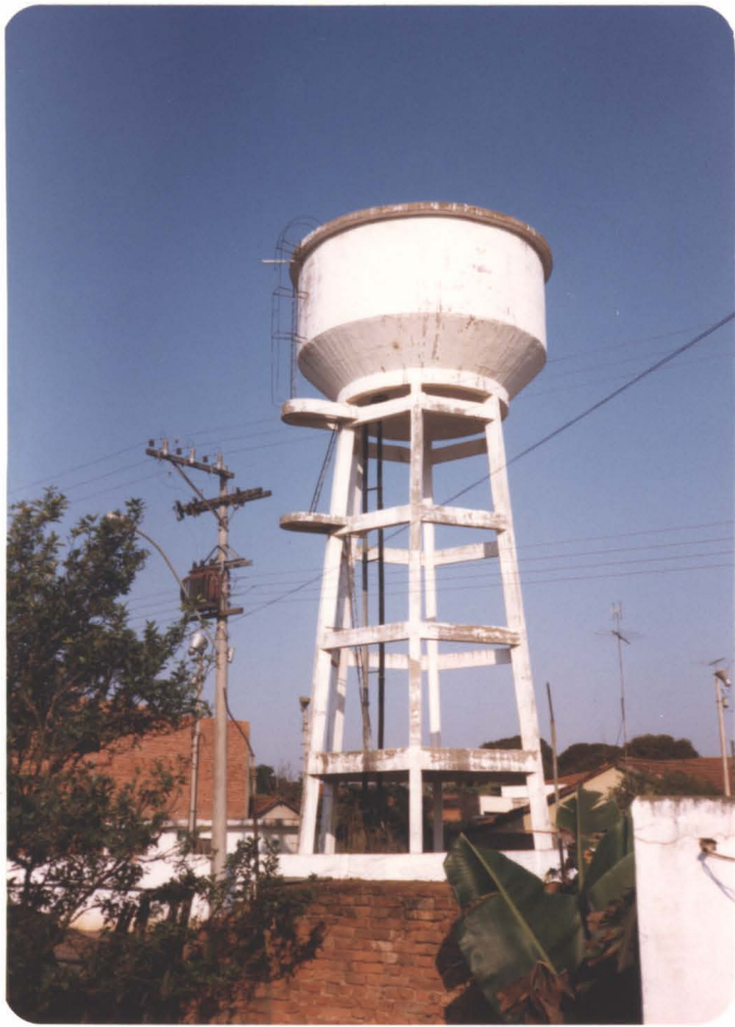
RESERVATÓRIO DE ÁGUA
