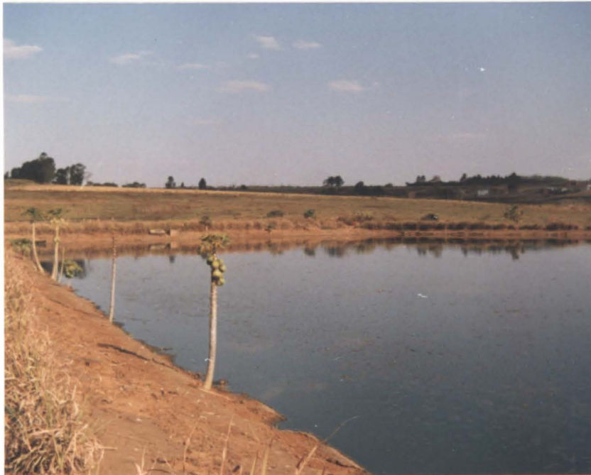
LAGOA DE ESTABILIZAÇÃO ( atual )
