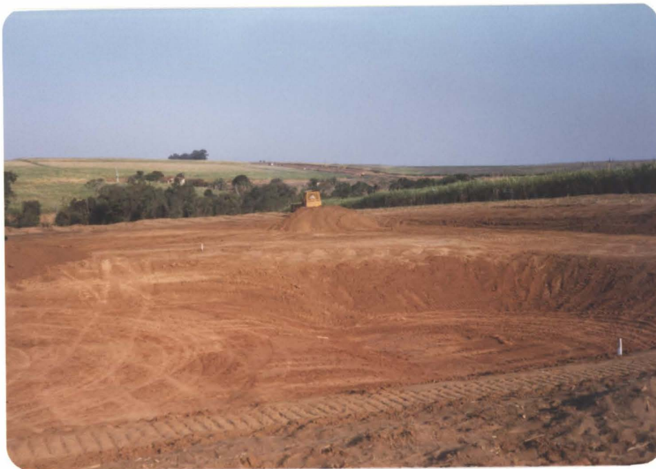
LAGOA DE ESTABILIZAÇÃO ( em construção )
