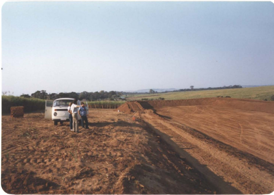
LAGOA DE ESTABILIZAÇÃO ( em construção )
