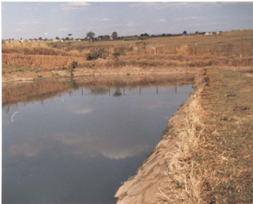
LAGOA DE ESTABILIZAÇÃO ( atual )
