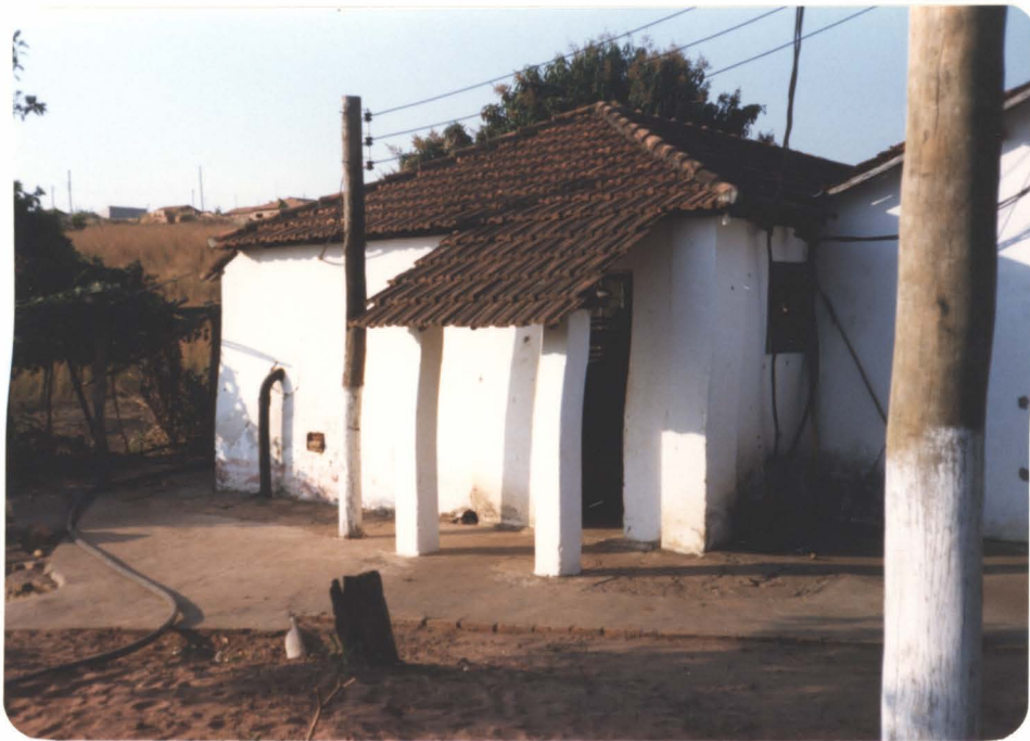
CAPTAÇÃO DE ÁGUA
