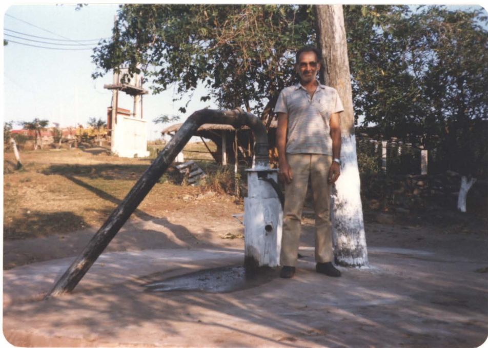
CAPTAÇÃO DE ÁGUA
