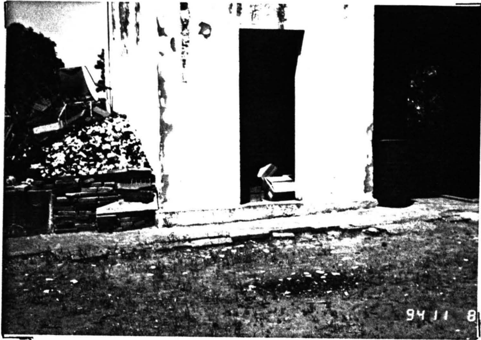
Nº 12 DEPÓSITO PRÓXIMO AO INCINERADOR (SANTA CASA) TUPI PAULISTA NOV/94
