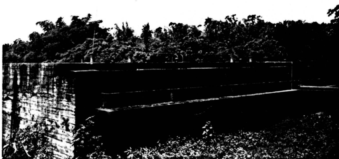
Foto 4.3: Tratamento de esgotos - Filtro Biológico.
