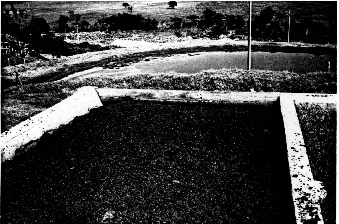
Foto 2.2: Matadouro Municipal: tanques de deposição do conteúdo do bucho do boi (1º plano), lagoa de decantação para tratamento de efluentes (2º plano). Ao fundo, leiras de compostagem da respectiva usina.
