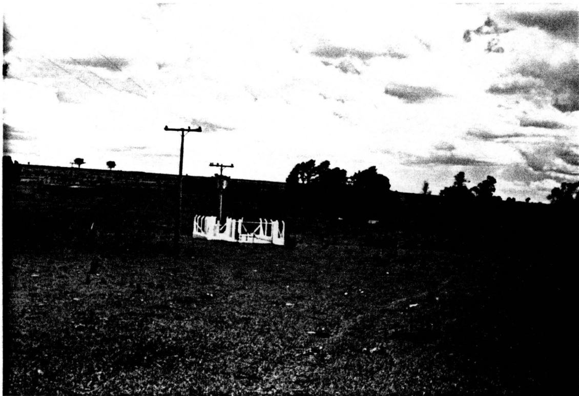
Foto 3.5: Vista da área do Poço Tubular Profundo nº 18.
