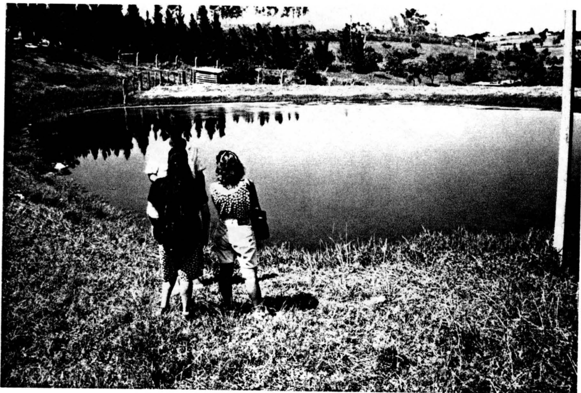
Foto 2.3: Detalhe da lagoa de decantação.
