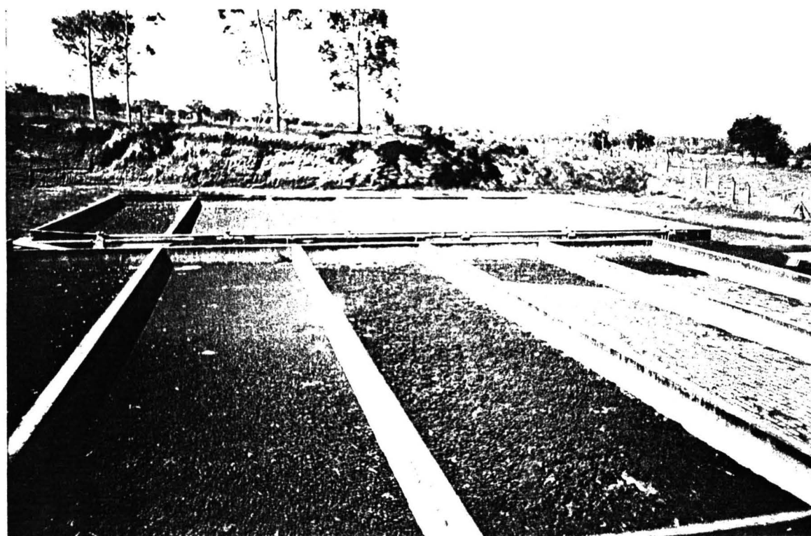
FOTO 6: Leitos de secagem
