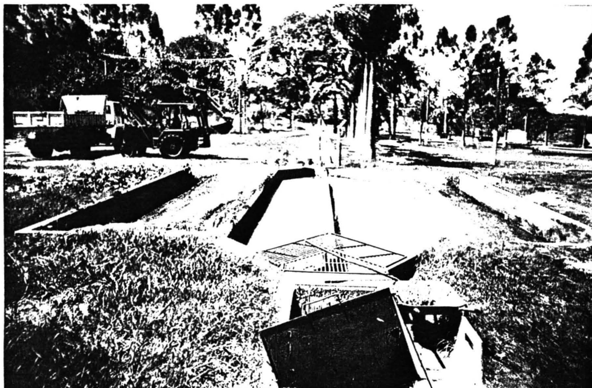
FOTO 01: Tratamento Preliminar - Grade, caixa de areia e calha Parshal
