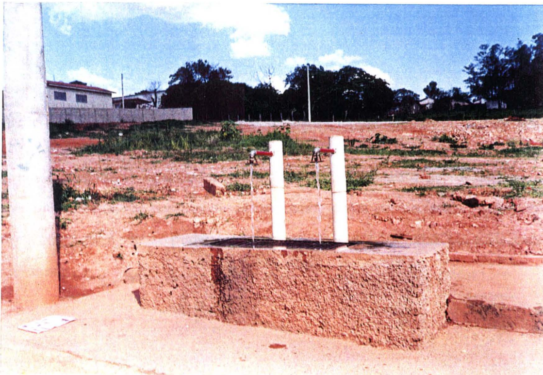
Foto nº 8: Sistema alternativo de abastecimento de água - nascente de encosta canalizada
