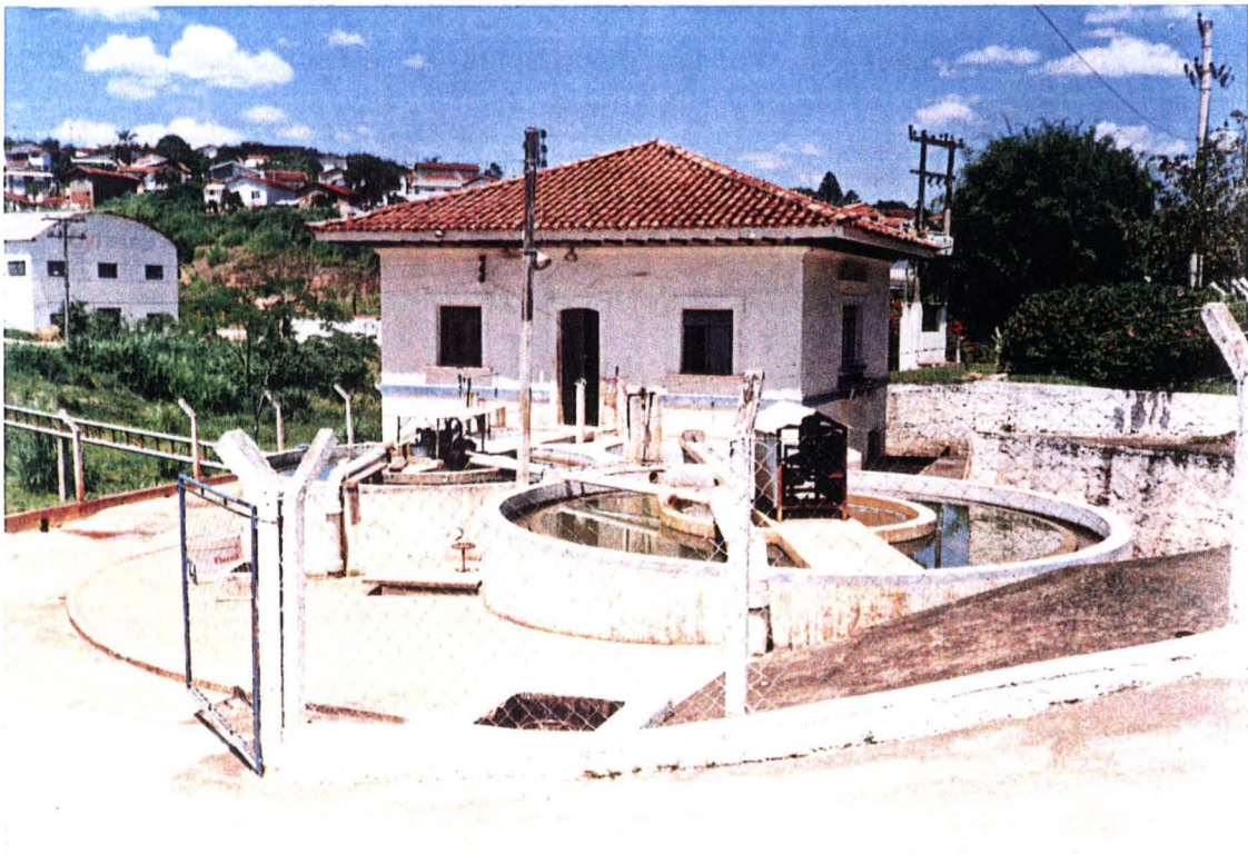
Foto nº 07: Estação de Tratamento de Água - ETA
