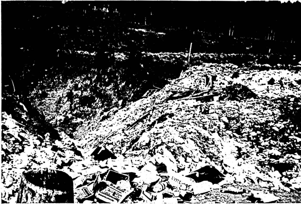
FOTO Nº 5 - DETALHE DA DISPOSIÇÃO FINAL DO LIXO DO “LIXÃO” CABECEIRA DE UMA ENORME EROSÃO
